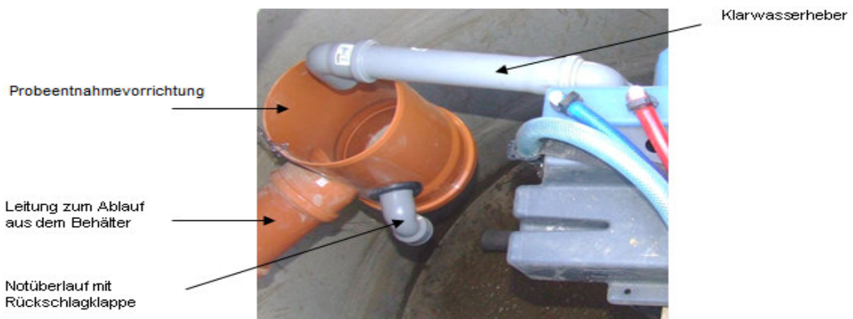
Abbildung 2: Probeentnahmevorrichtung (Installationsbeispiel)
